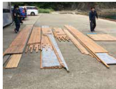
パネルのような形に組み上げられて、コンテナに収載できるサイズのユニットで日本に運ばれてくる。船上での作業量は大きく減少し、工期という観点から見てもかなり短縮されている
