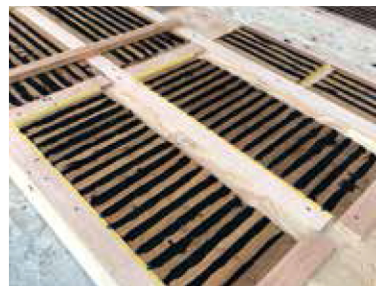
コーキング剤を注入したところ。あらかじめ多めに盛ることで、硬化した後の「やせ」も計算に入れている。約1週間で、内部まで硬化すること
